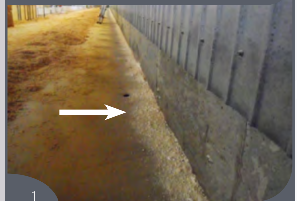
1 Εφαρμογή εντομοκτόνου πριν από την τοποθέτηση νεοσσών
