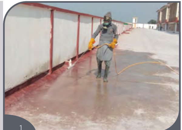
1 Εφαρμογή εντομοκτόνου εκτός του κτιρίου
